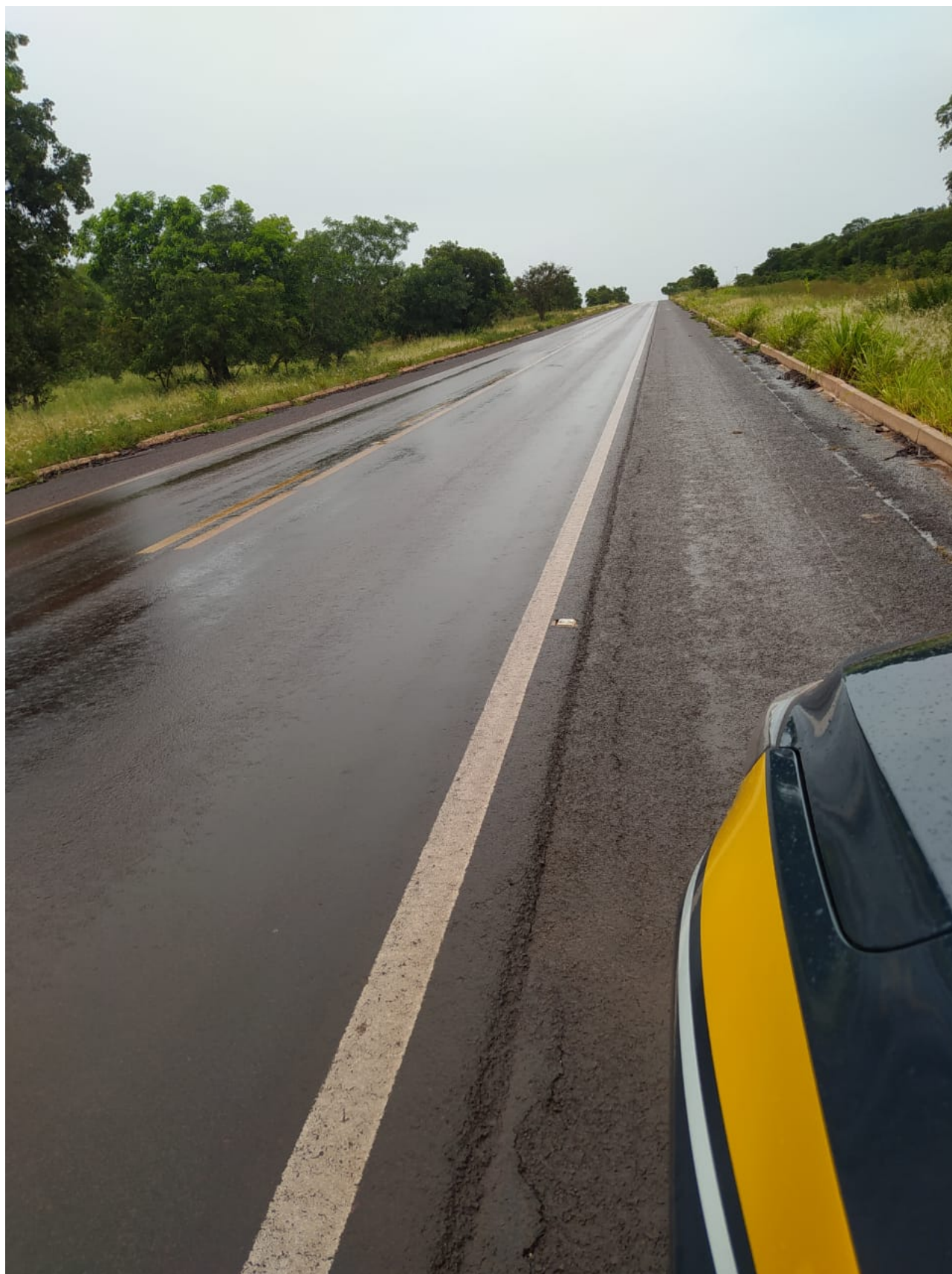
s) Km 225,1 Crescente. Sem Sinalização vertical de proibido ultrapassar;
