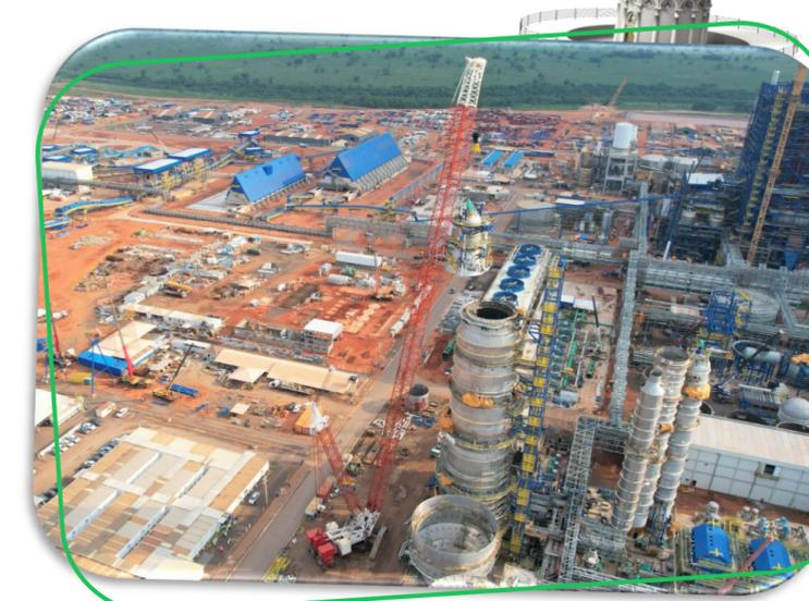
Portanto, o Digestor realmente cozinha a madeira que é lançada em seu interior em forma de cavacos e misturada a produtos químicos, como licor branco (uma solução alcalina) e vapor, alcançando temperaturas acima de 150°C e altas pressões. Após o cozimento, a mistura resultante é transferida para outros equipamentos, como lavadores e peneiras, para separar a fibra de celulose da lignina e de outros resíduos.
